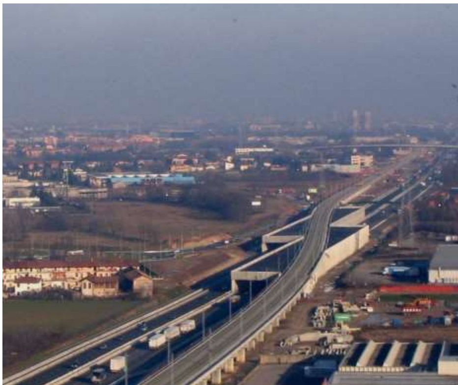
Intersezione con l'autostrada A4 nella tratta Torino-Milano - Pregnana Milanese - Italia. Realizzazione di due gallerie artificiali sulla linea Alta Velocità. Consulenza strutturale per la sostituzione di elementi gettati in opera con elementi prefabbricati. Anni: 2004 ÷ 2006
