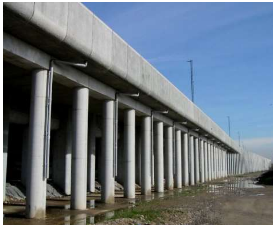
Intersezione con l'autostrada A4 nella tratta Torino-Milano - Pregnana Milanese - Italia. Realizzazione di due gallerie artificiali sulla linea Alta Velocità. Consulenza strutturale per la sostituzione di elementi gettati in opera con elementi prefabbricati. Anni: 2004 ÷ 2006
