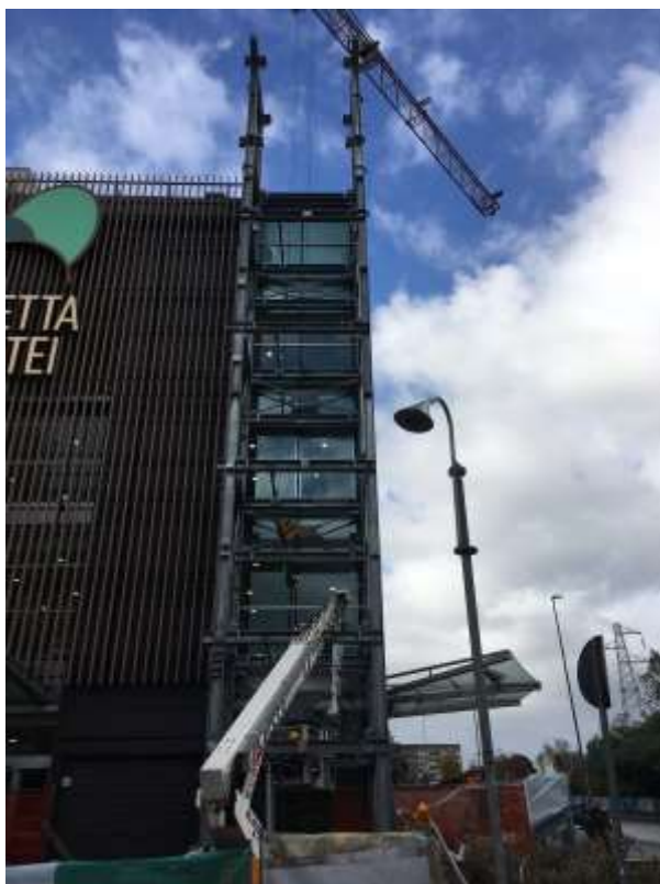
L22 Lombardini22 S.p.A. - Realizzazione di una pensilina e di un vano ascensore in acciaio per il centro commerciale Casetta Mattei sito in Via dei Sampieri - Roma - Italia
