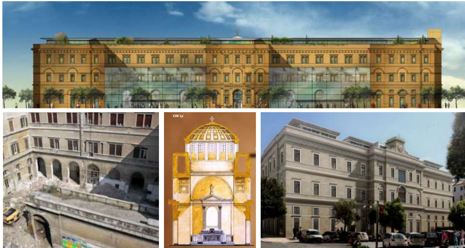
Complesso residenziale San Paolo - Ristrutturazione ex ospedale San Paolo - Savona - Italia.
