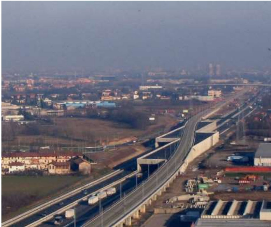
Intersezione con l'autostrada A4 nella tratta Torino-Milano - Pregnana Milanese - Italia. Realizzazione di due gallerie artificiali sulla linea Alta Velocità. Consulenza strutturale per la sostituzione di elementi gettati in opera con elementi prefabbricati. Anno: 2004 - 2006
